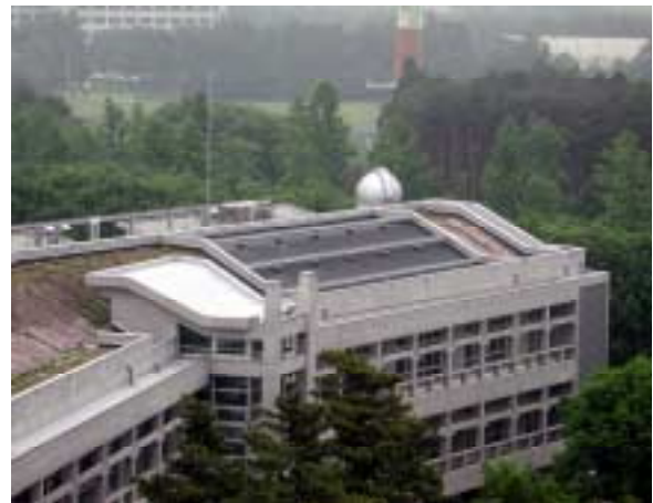
写真2 各種屋上面施工用テスト部位
