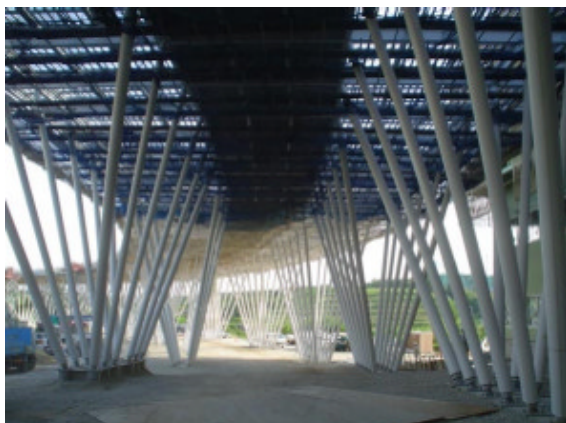
写真3 グローバルループ(写真は工事中のもの：上段の遊歩道に完全に遮られることなく下層にも光が漏れている。)
