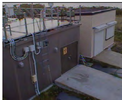
屋外カメラからの映像写真
