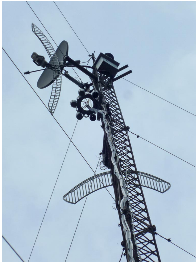
写真8, 9, 10, 11 タワーへ設置されたインレット
