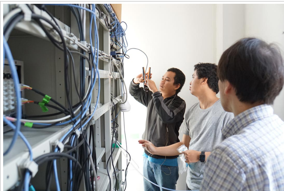
写真12 IPB/CCROMのスタッフによる通信回線の配線作業
