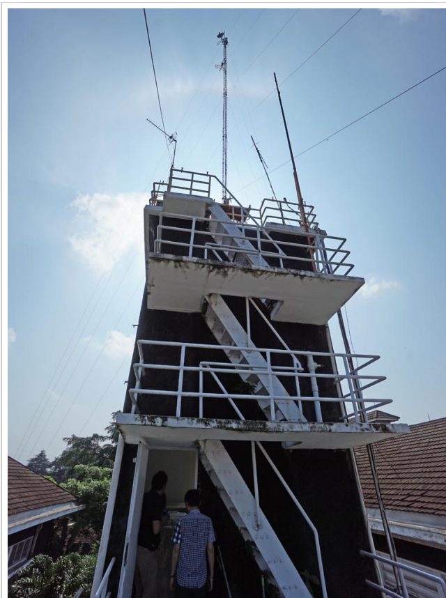
写真2 観測システムを設置したIPBキャンパス内の給水施設
