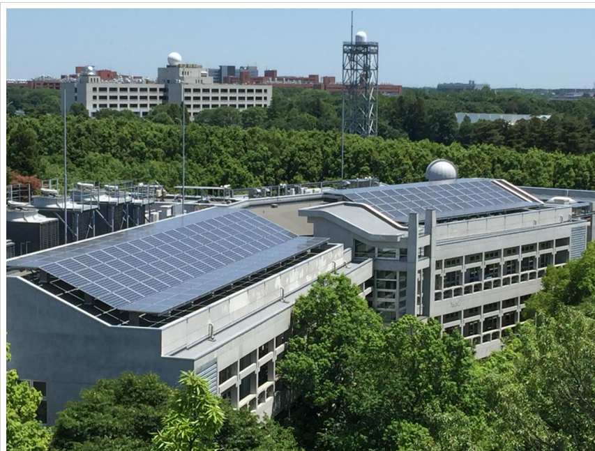
写真2 屋上緑化していた部分（写真左側）にも太陽光パネルを設置しました
